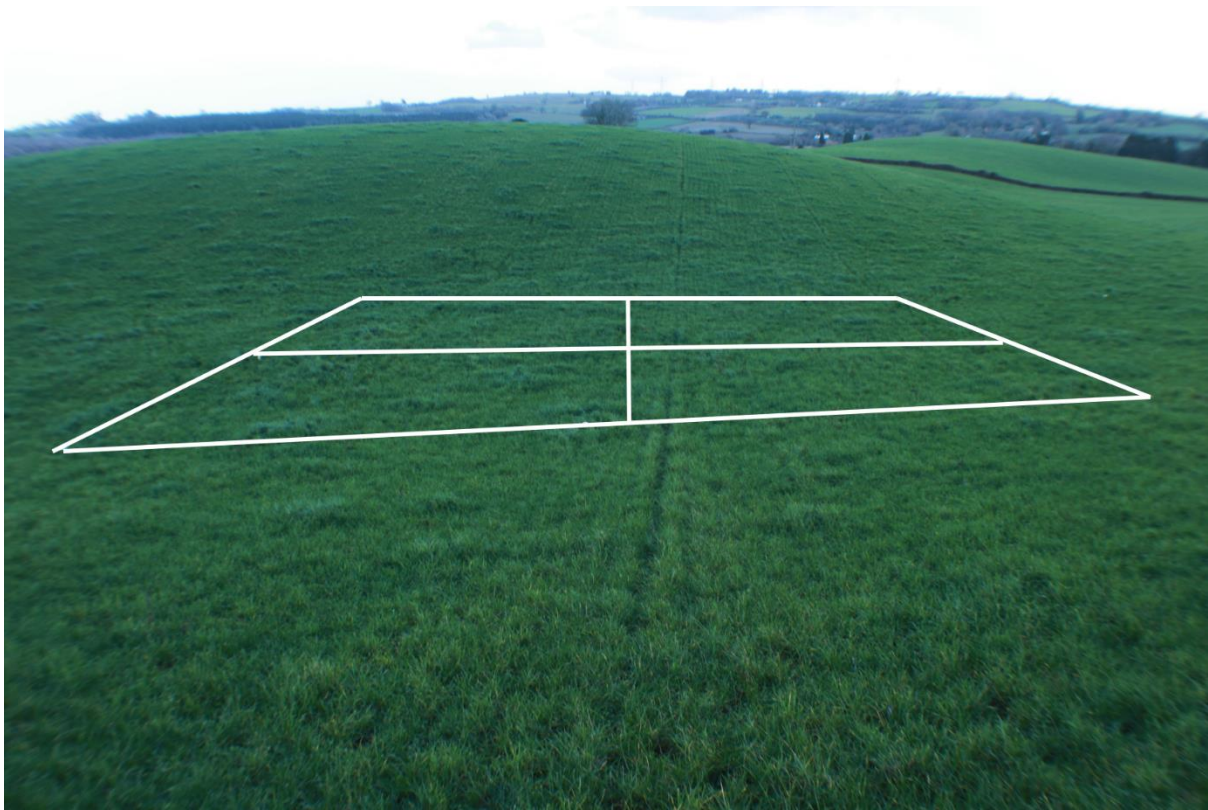
Ffigur 4. Grid o safleoedd wedi'u fflagio yn dynodi y colofnau sylfeini / Figure 4. Grid of flagged positions indicating column foundations
